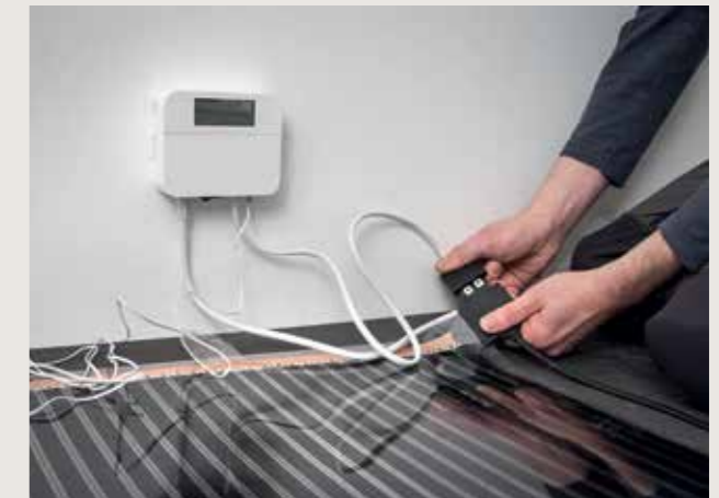
4 Installera styrenheten på väggen och anslut den till värmefolierna.
