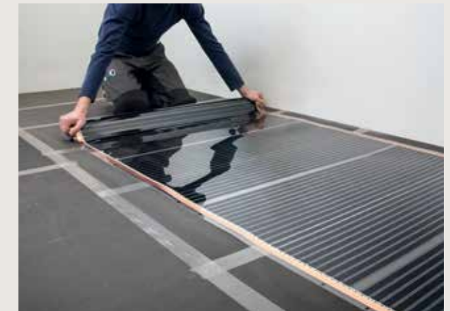
2 Installera QuickHeat-systemet i flera lager.
